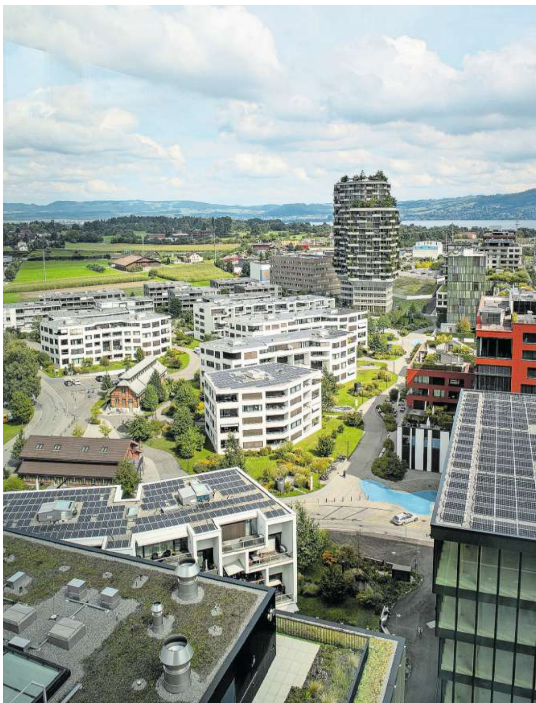
Die Suurstoffi in Rotkreuz zeichnet sich durch verschiedenartige Bauten aus.
