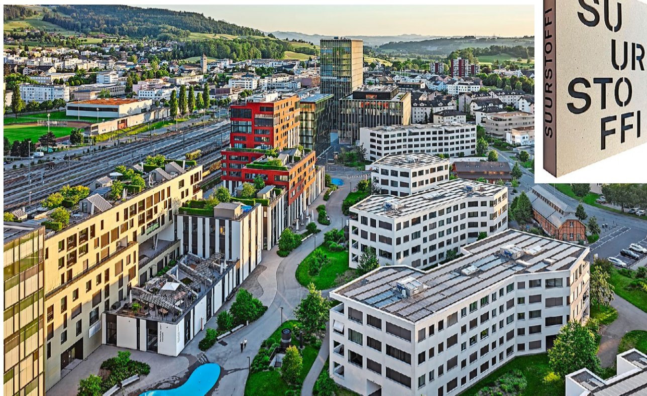
Die «Suurstoffi»: Ein einst unattraktives Areal wurde in den vergangenen zehn Jahren mit Leben, Inhalten und Zielen gefüllt. Das neu erschienene «Suurstoffi-Buch» (oben rechts) stellt die pionierhafte Entwicklung des Areals auf eindrückliche Weise dar und beschreibt das Quartier, wie es sich heute präsentiert.
