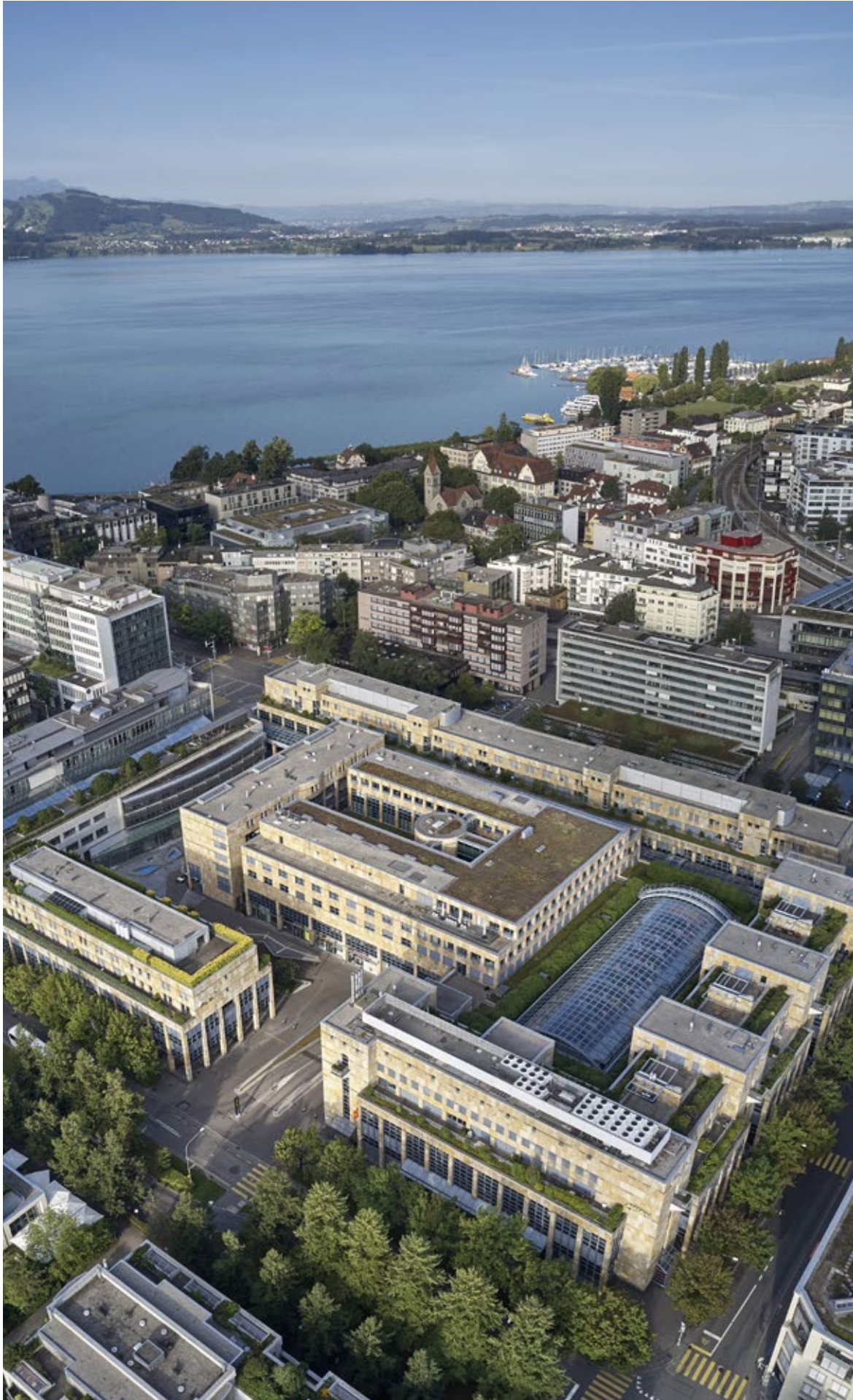
City centre site/Metalli, Zug
