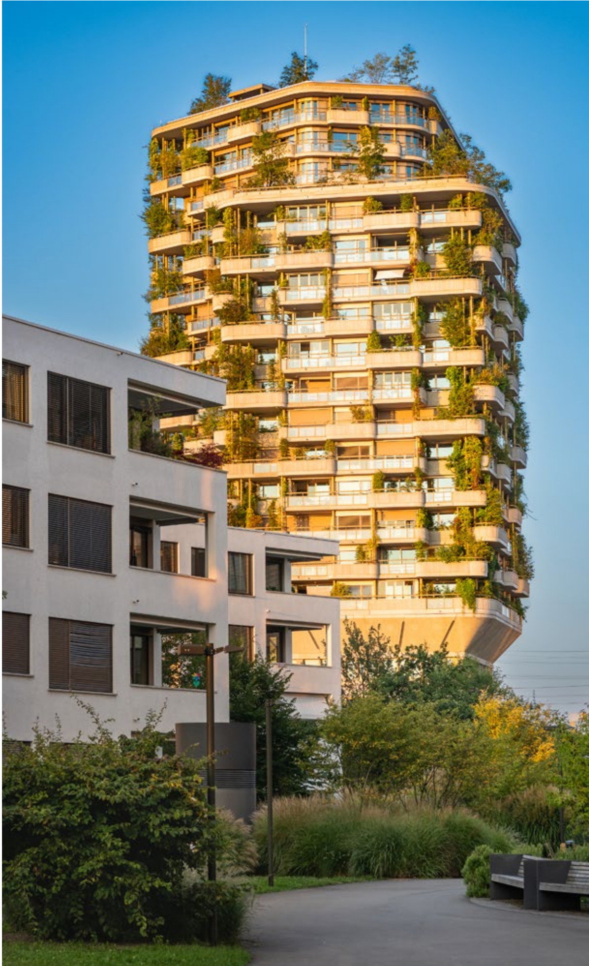
Gartenhochhaus Aglaya, Suurstoffi-Areal, Risch-Rotkreuz
