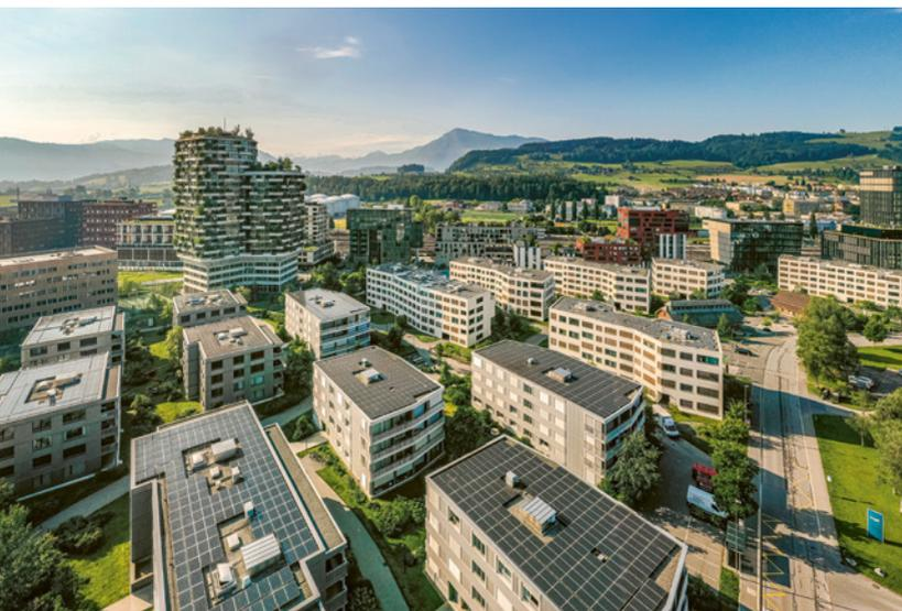
Auf 24 der 28 Gebäude in der Suurstoffi befinden sich Photovoltaikanlagen. Die installierte Leistung beträgt 1 530 kWp. Von den im 2021 produzierten 1 140 MWh Strom wurden 86% auf dem Areal verbraucht.
