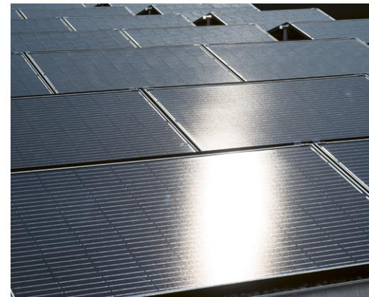
Fast 5800 Solarmodule mit einer installierten Kapazität von 1511 kWp wurden in der Suurstoffi verbaut.
