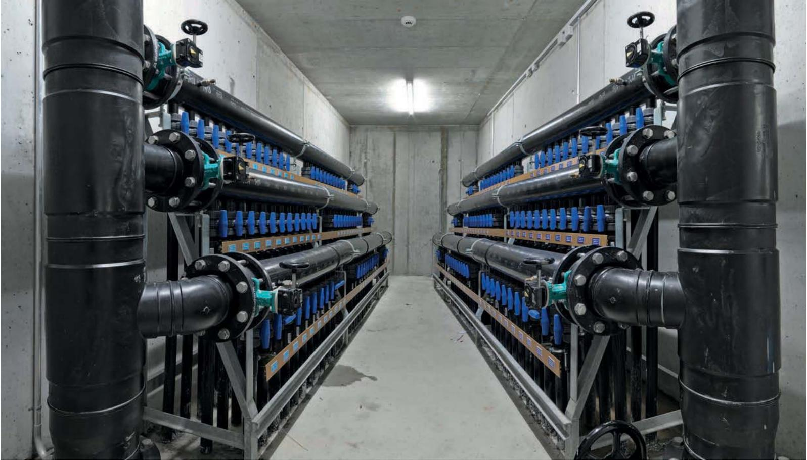
Blick in einen Technikraum der Suurstofli. Die Verteilung der Erdwärme erfolgt über ein zentral gesteuertes Energienetz.
